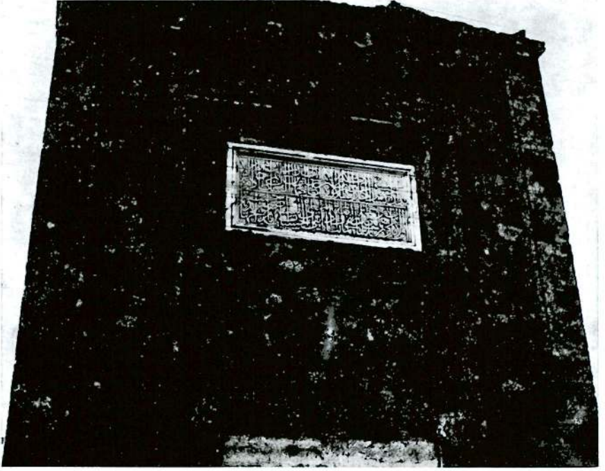
Res. 7 — Mustafa Paşa köprüsünün kitabe köşkü (Foto , S. Eyice 1964).
