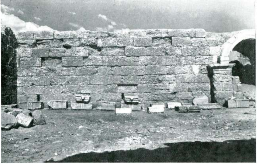
Res. 33 — Avlunun kuzey yan duvarı
