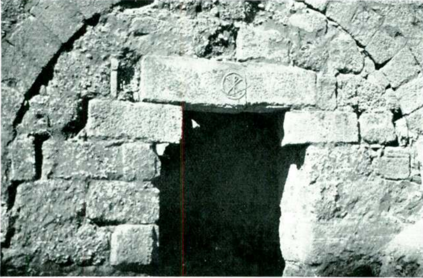
Res. 8 — C geçidinin doğu cephesi
