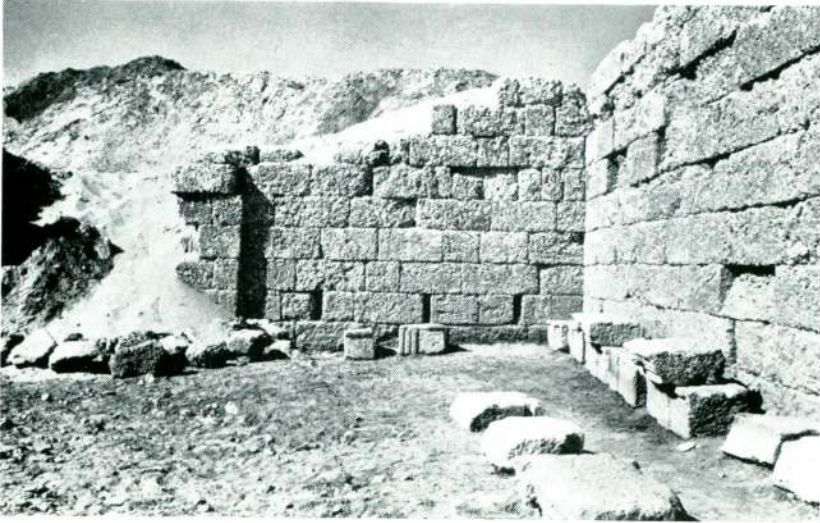
Res. 24 — Avlunun batı duvarının kuzey kısmı
