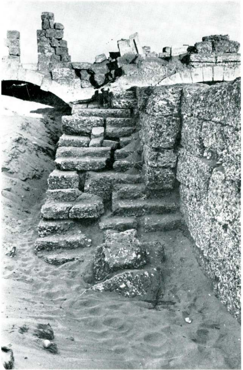
Res. 19 — Avlunun kuzey yanındaki merdivenin cepheden görünüşü
