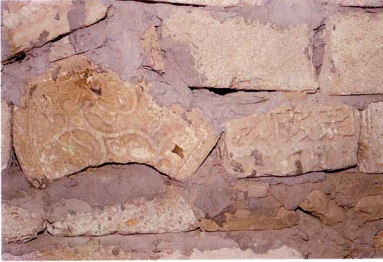
Resim 3 - Azerbaycan / Mereze, Diri Baba Türbesi. Kitabe parçalarının restorasyonda duvara yerleştirilmiş örnekleri (Fotoğraf Yaşar Çoruhlu, 1997).
