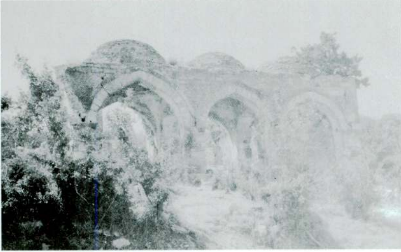
Res. 5 – Çeşme köyü'nde cami harabesi
