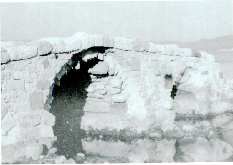
Res. 10 – Köprünün 1989 başındaki durumu
