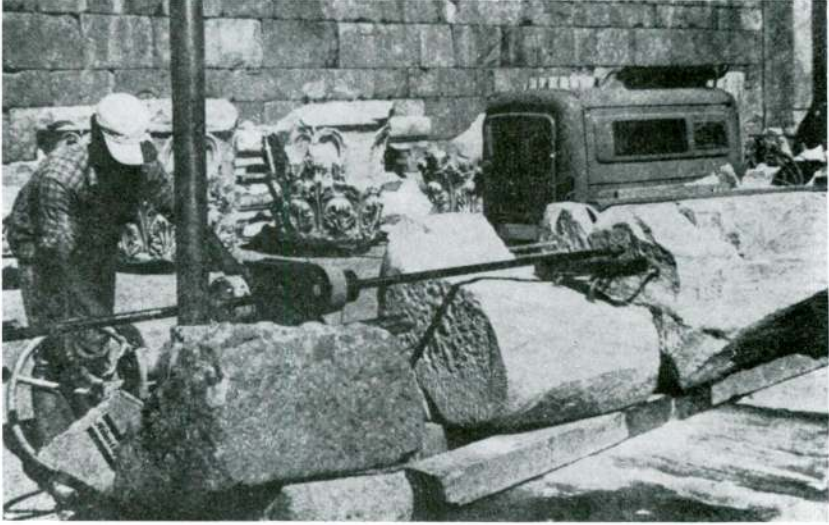
Res. 31 — Hareketli ve ayarlanabilen matkapla delik delme (Rad'tan).
