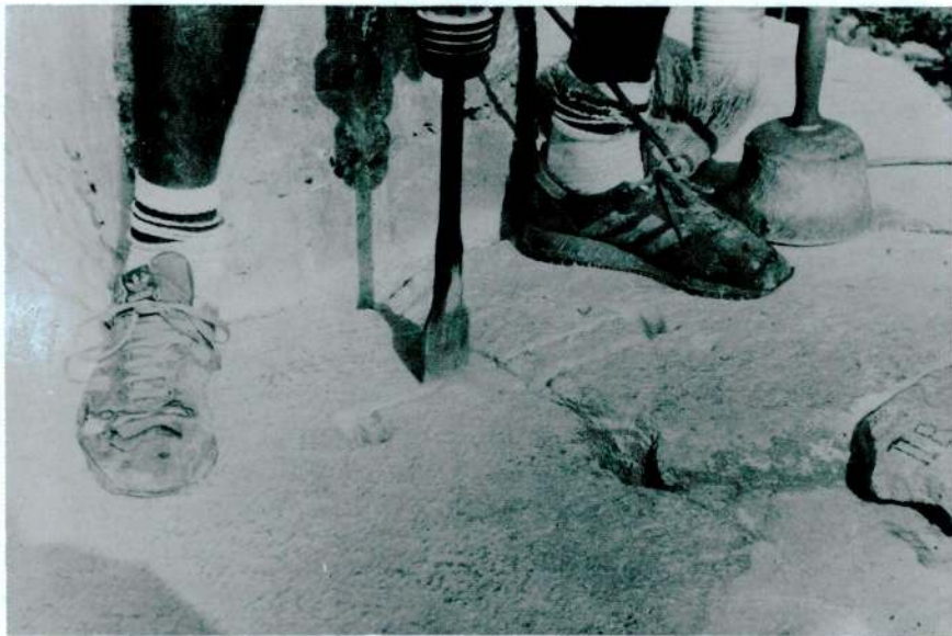
Res. 39b — Kenet yuvasının kenarlarının sınırlandırılması.
