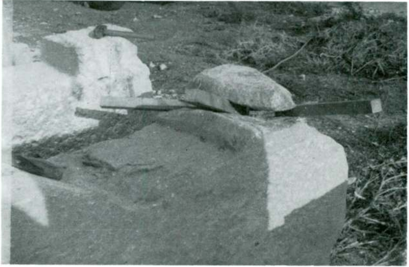
Res. 23 — Güçlendirici kullanılarak yanlış birleştirilmiş parçaya ahşap kama çakarak ayırma.
