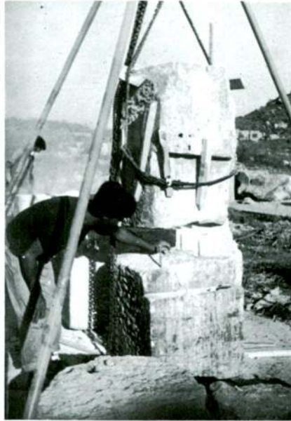
Res. 24 — Metal çubuk kullanarak iki parçanın birleştirilmesi.
