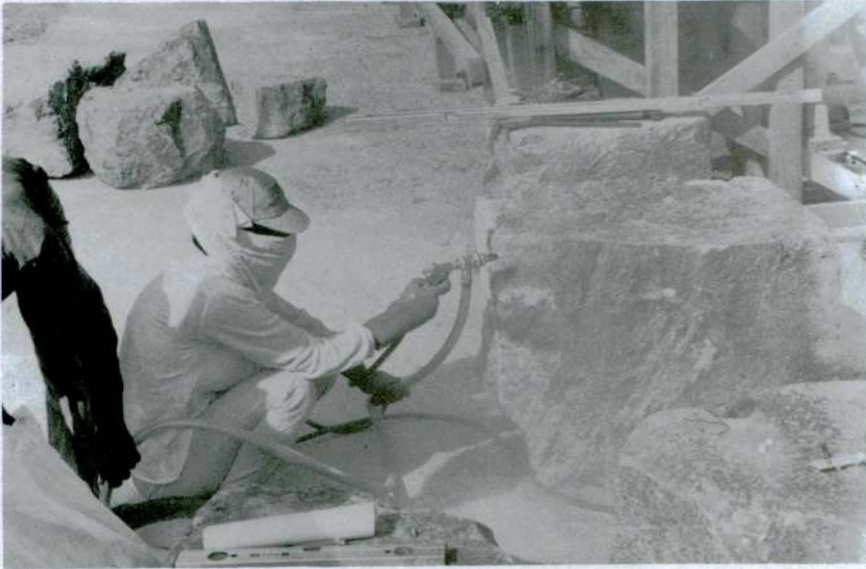
Res. 22 — Basınçlı kum püskürtülerek kırık yüzeyin temizlenmesi.
