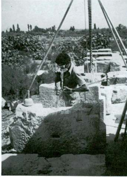
Res. 5 — Beton kolon geçirileceđi düşünceyle ortasının oyulması.
