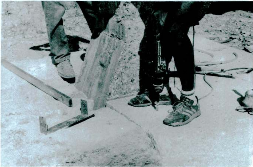
Res. 39a — Kenet yuvalarının açılması.
