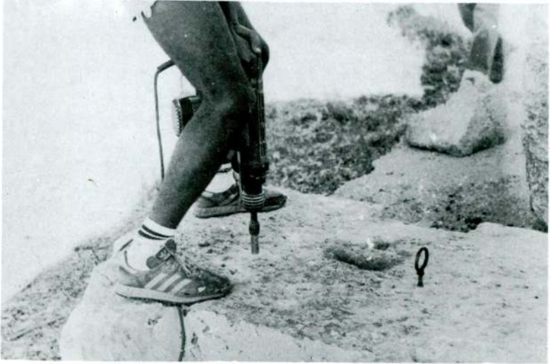
Res. 16 — Matkap kullanarak dübelin yerleştirilmesi.
