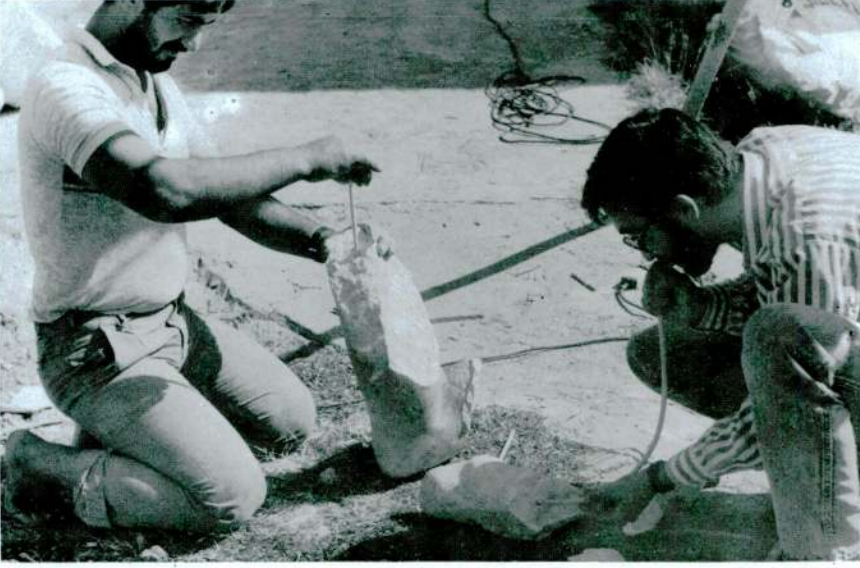
Res. 37 — Kıvrılabilen hortum kullanılarak delik içinin temizlenmesi.
