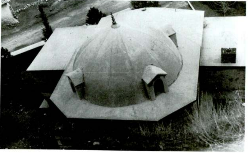
Res. 24 — Akşemseddin Camisi - Örtü (Onarımdan sonra)
