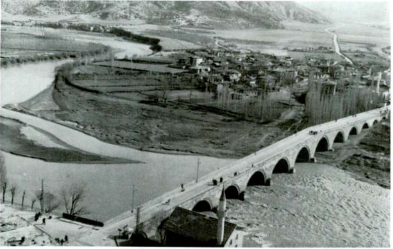
Res. 4 — Osmancık Koyunbaba Köprüsü
