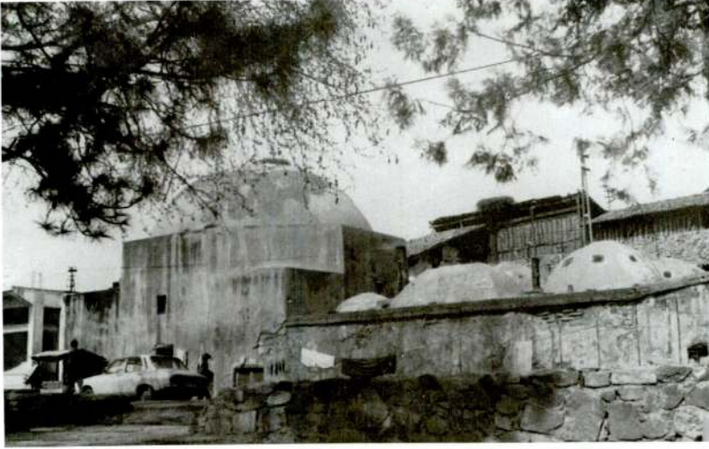
Res. 26 — Paşa Hamamı - Giriş yüzü
