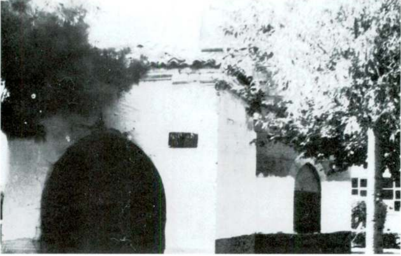
Res. 9 — Ayı Ali Türbesinin Giriş Cephesi
