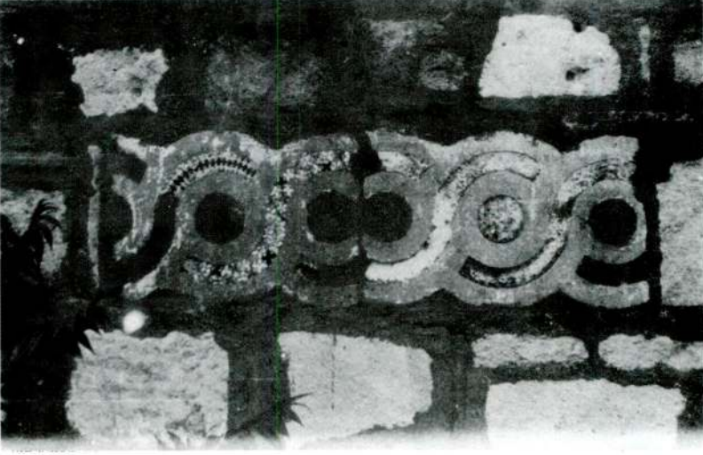
Res. 5 — Revak Sultan Türbesinin Güney Duvarındaki Bizans Süslemesi
