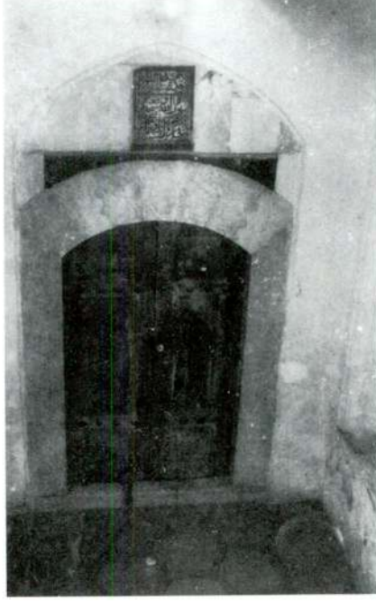
Res. 13 — Vakvak Tekkesinin Giriş Cephesi
