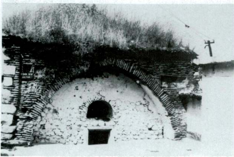
Res. 7 — Yedikızlar Türbesinin Doğu Cephesi
