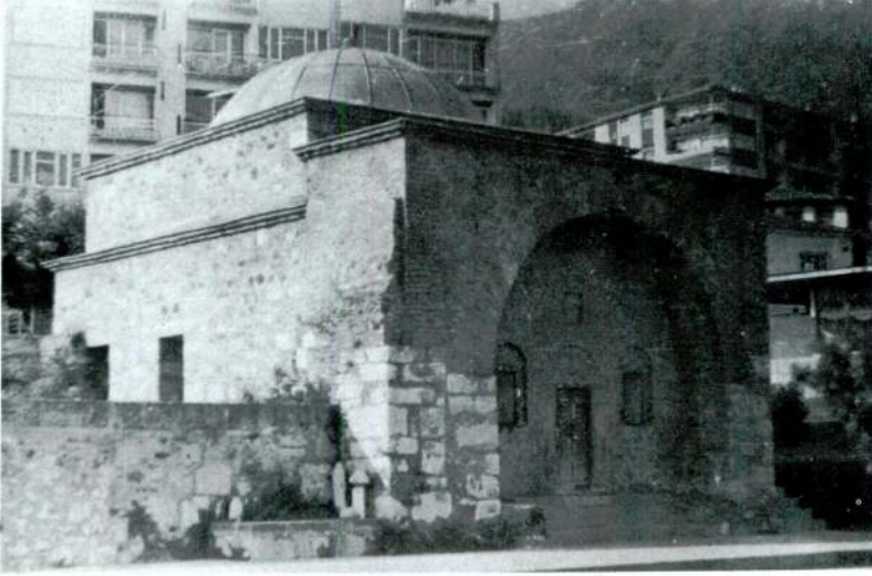
Res. 1 — Saruhan Bey Türbesinin Kuzeydoğudan Görünüşü
