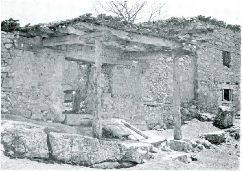
Res. 4 — Batı cephe, avluya giriş kapısı
