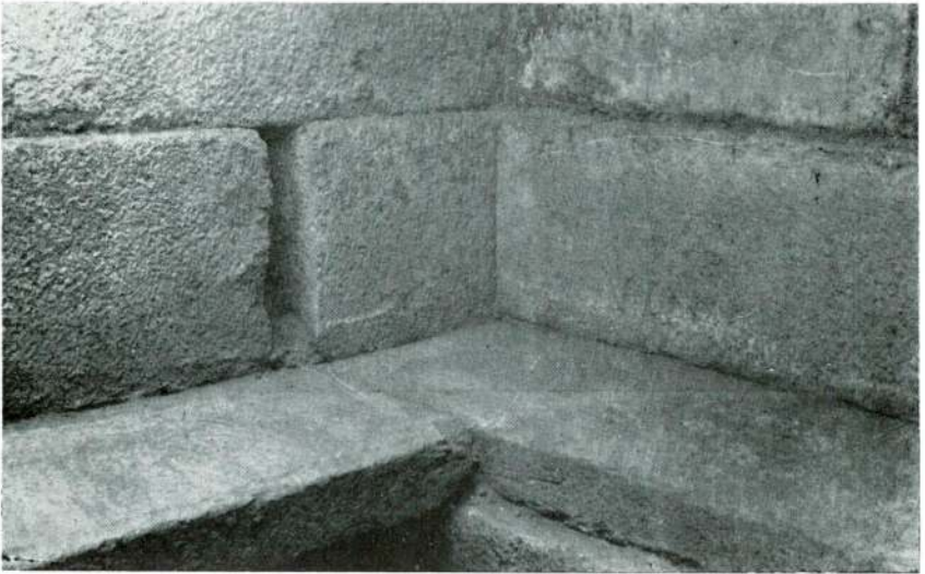
Alabanda mezarının doğu köşesi (duvardaki aralık yatak korkuluğunun yuvasıdır).
