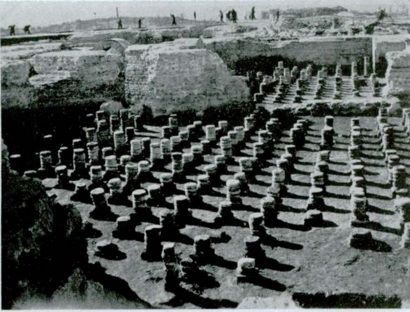
Döşemeyi taşıyan mesnet direkleri. «Yuvarlak tuğlalar»
