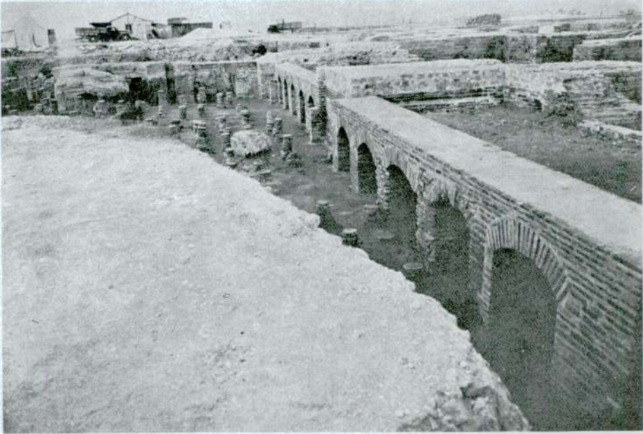
«Caldarium» da Kemerler
