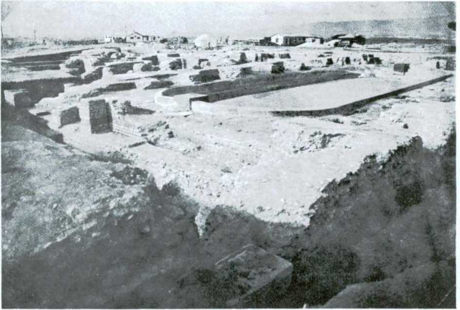
Klâsik Hamam Umumî Görünüş
